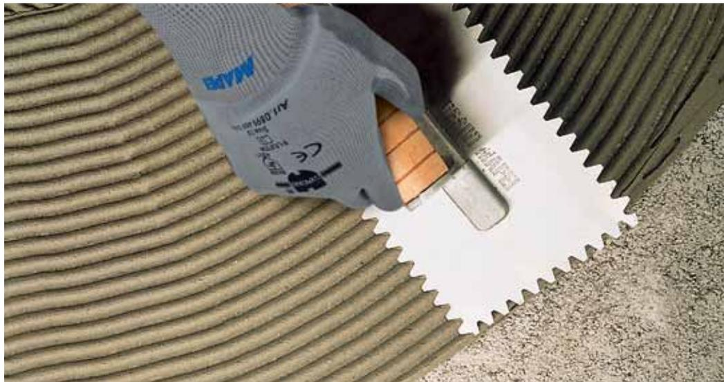
absorbentes o aislantes, aplicar **Adesilex P9 Porcellanato** con lana dentada por puntos.
