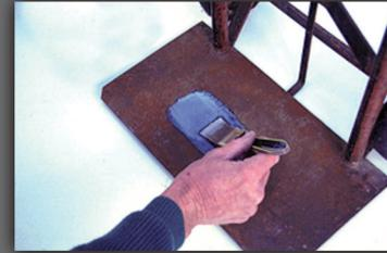
3. De existir óxido, aplique una mano de convertidor de óxido, en sup. sin óxido, una mano de antióxido.
