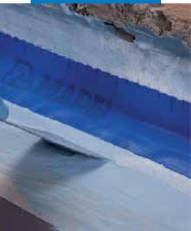
Aplicación de Mapeband en la unión pared-piso con Mapelastic AquaDefense
